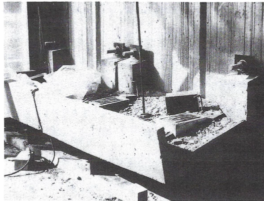
FIG. 16. Precast Stiffener Segment
